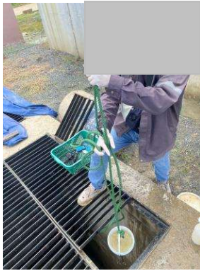
บ่อตรวจสอบคุณสมบัติน้ำทิ้งในระบบบำบัดน้ำเสียทางเคมีของ โรงงานที่อาจมีน้ำเสียเคมีปนเปื้อน
